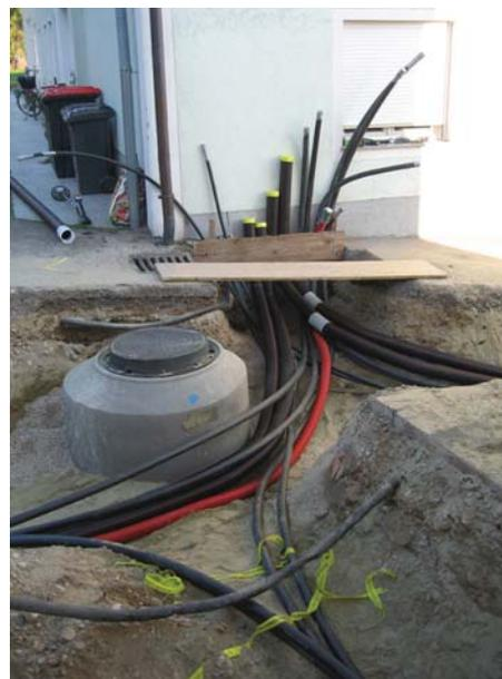
In diesem Zuge wurden auch bestehende defekte Wasserleitungen saniert und für die Stromfreileitungen und Internetkabel Leerrohre mitverlegt.
